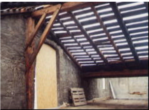
Blick zur Südwand
