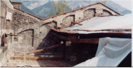
Man sieht hier an der Nordwand die alte Höhe des Daches
