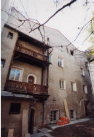
Hoffassade vor dem Umbau
