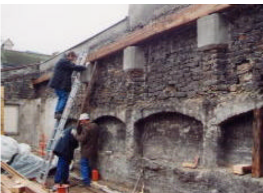
Westwand mit sanierten Pfettenauflagern
