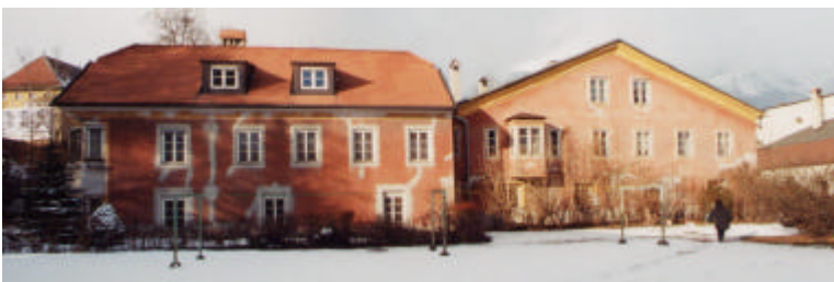
Südseite des Objektes mit linkem späteren Anbau
