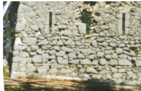
„Orthofoto“ entzerrt und parallel zur Wand im Maßstab 1:25
